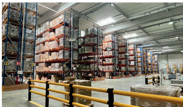
HUB 1 : Stockage en racks 18 000 m 2 de stockage racks et zones de préparation
