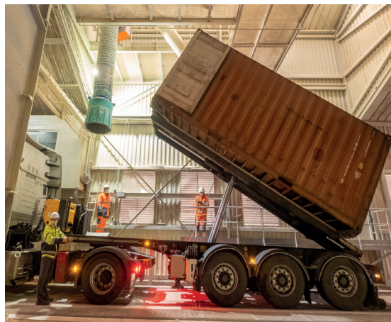
Création d'une installation de chargement mixte, de conteneurs et de bennes vrac, dédiée à Tereos sur le site de Sénalia Lillebonne.
