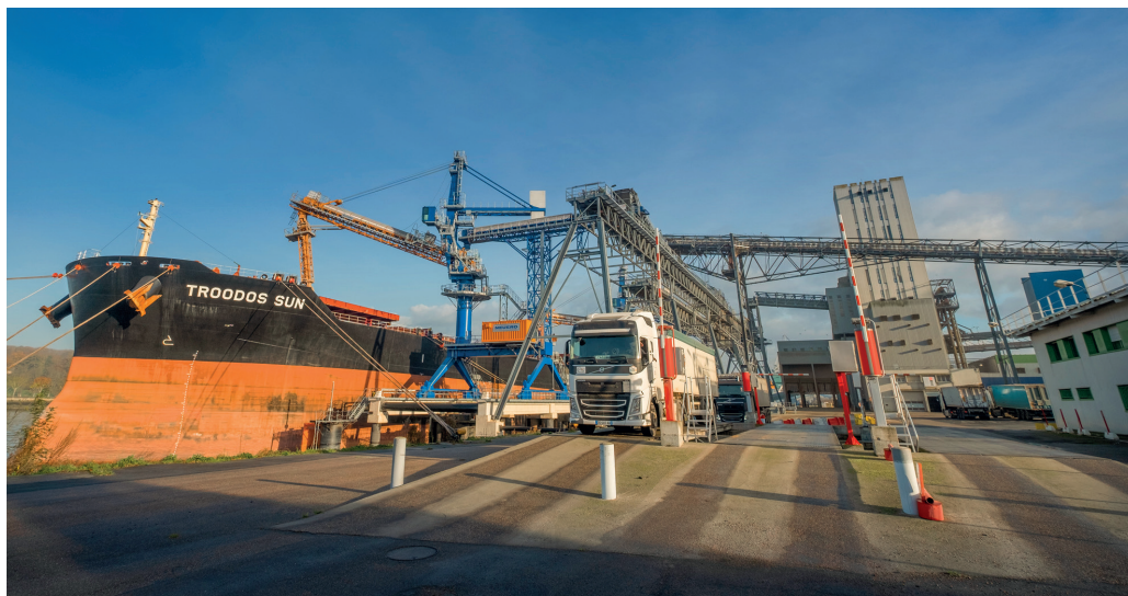
Chargement d'un navire sur le site Sénalia de Grand-Couronne avec les nouveaux portiques, qui permettent de charger à 3000 t/h sans émanation de poussière.
